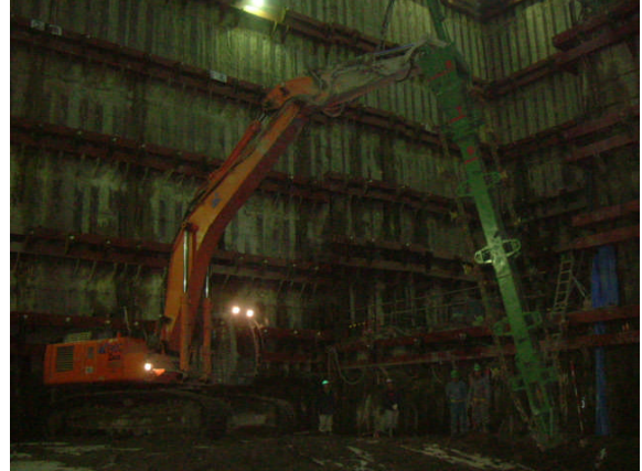
写真-1 トレンチャー型地盤改良専用機
