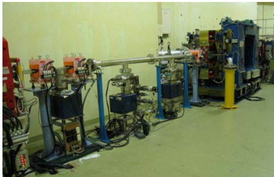
図2 円偏光アンジュレータU#16-1 (奥)と軌道スイッチング用キッカー電磁石 (桃色)。写真中央のダミー管部がU#16-2号機の設置スペース。
