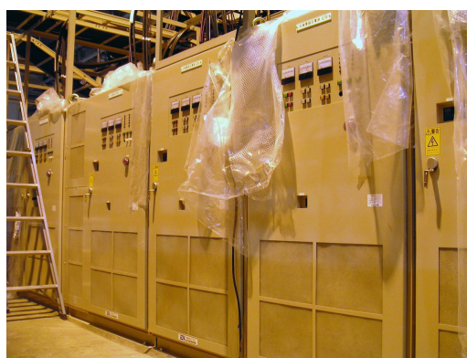
図5 4極電磁石用電源
