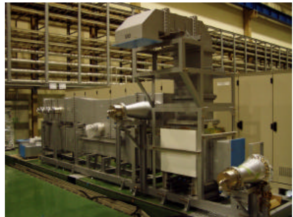
写真1 設置工事中の立体回路(1ユニット)
