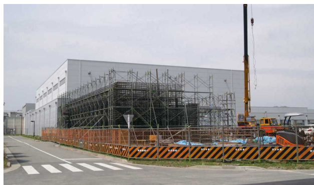
図2 組立調整棟、SCSS試験加速器建設(2005/05)
