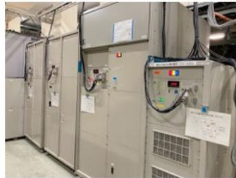
入射器に6台残っている20年以上使用された電磁石電源
